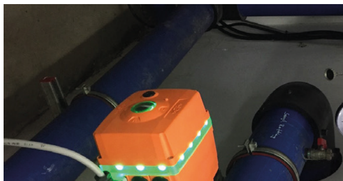
L'affichage LED à 360° facilite la vérification de l'état actuel de l'actionneur..
