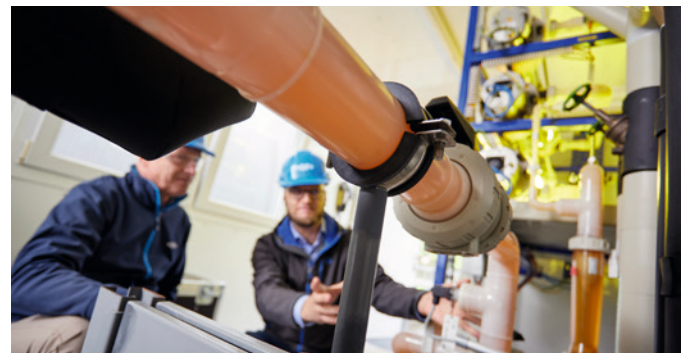
Für den sicheren Transport von hochaggressiven Chemikalien entschied sich Merck & Cie für das SYGEF ECTFE System von GF Piping Systems.
