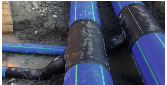
Sicher und effizient: Mit werkseitig-fabrizierten T-Stücken lassen sich Abzweige im Graben einfach, schnell und zuverlässig herstellen.
