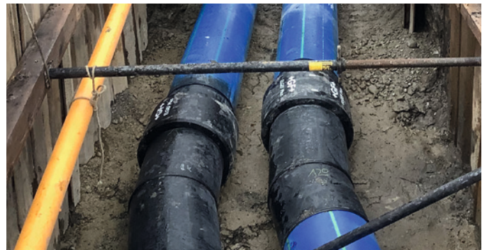
Problemlos und wirtschaftlich: Fixpunktanbindungen mit ELGEF Plus-Muffen.
