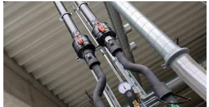
Die Kugelhähne Typ 546 im Einsatz in der Druckerei.
