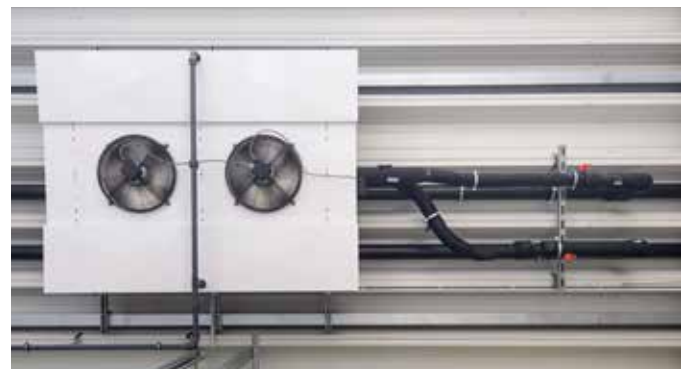
Der Anschluss an die Umluftkühler mit COOL-FIT 2.0
