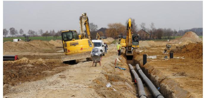
Im Neubaugebiet „Neuer Soester Norden“ werden Rohre verlegt, die später die Wärme aus dem Erdreich zu den 600 Wohneinheiten transportieren.
