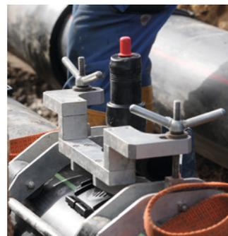
Für das Nachhaltigkeitsprojekt kommen u. a. Druckbohrventile von GF Piping Systems zum Einsatz. Sie sind vor dem Schweißen um 360° drehbar.
