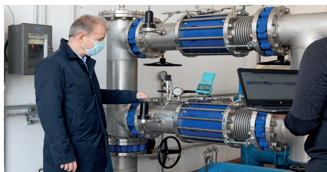
Installazione di una valvola regolatrice di pressione NeoFlow DN100.
