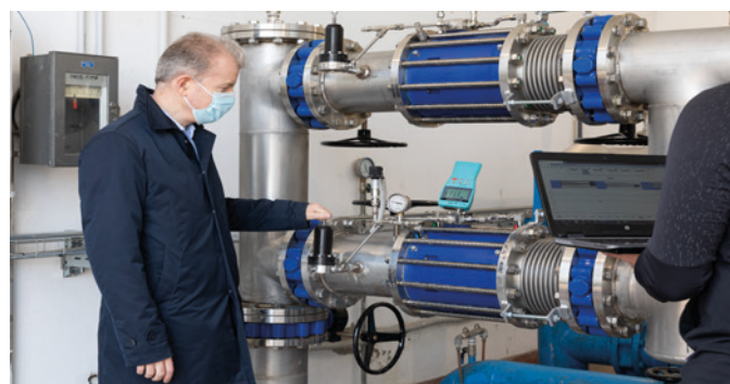
Installation d'une vanne de régulation de pression NeoFlow DN100.
