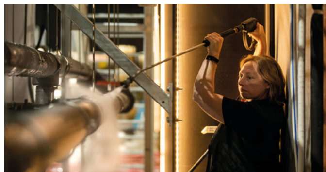
Avec une enveloppe extérieure robuste et une lèvre d'étanchéité, le système COOL-FIT sans corrosion peut être facilement nettoyé sous pression.
