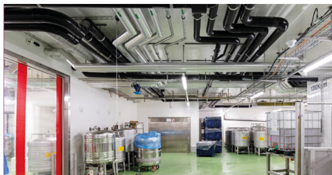
La modernisation a concerné une section d'environ 150 mètres.
